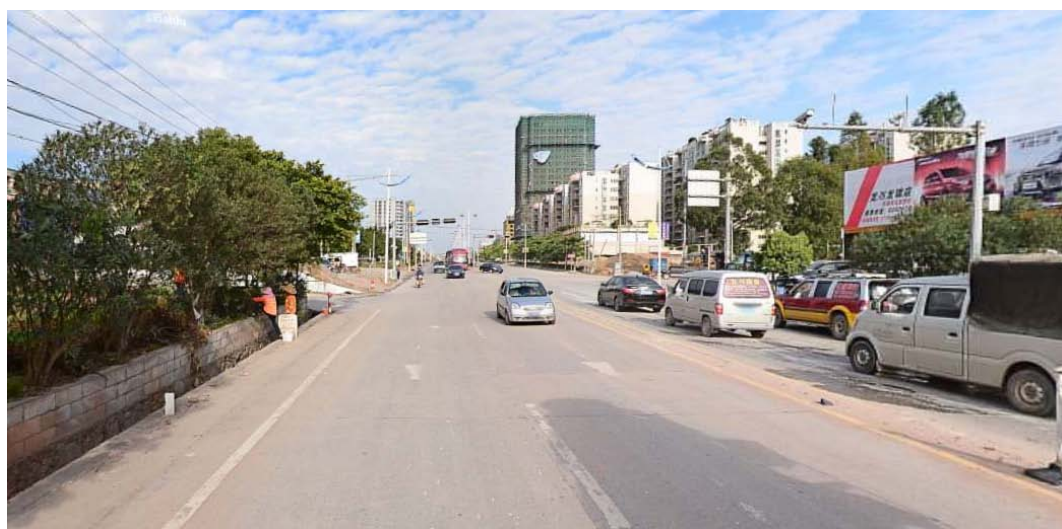
图 3-7 国道 G205 现状
