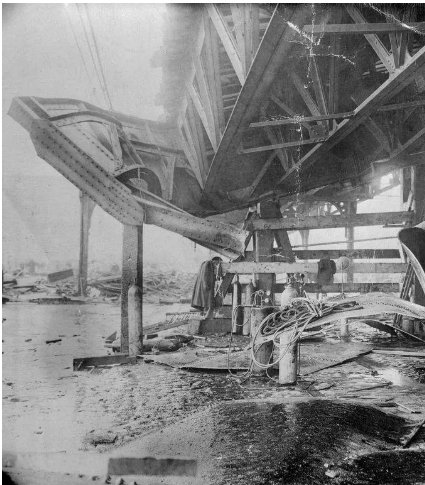
被糖蜜洪流与钢板碎片破坏的高架铁路 | Wikipedia
