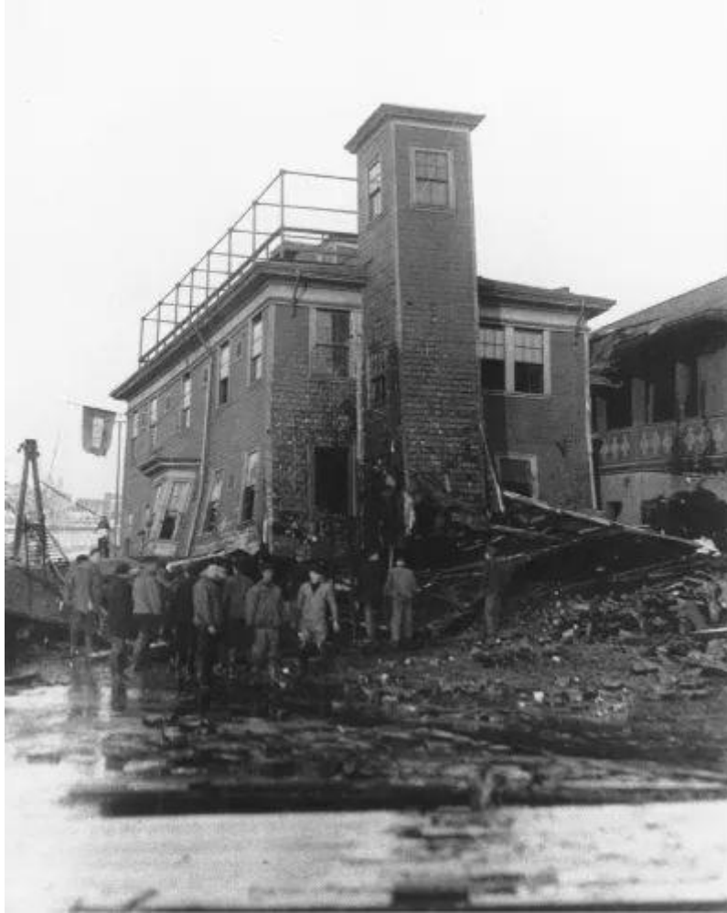
被从地基上扯下、部分塌陷的港口消防站 | Bill Noonan, Boston Fire Department Archives
