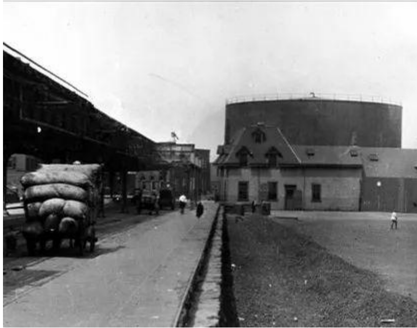
位于波士顿北区码头的巨大糖蜜储存罐（拍摄于灾难发生前，具体时间不明） | The Bostonian Society
